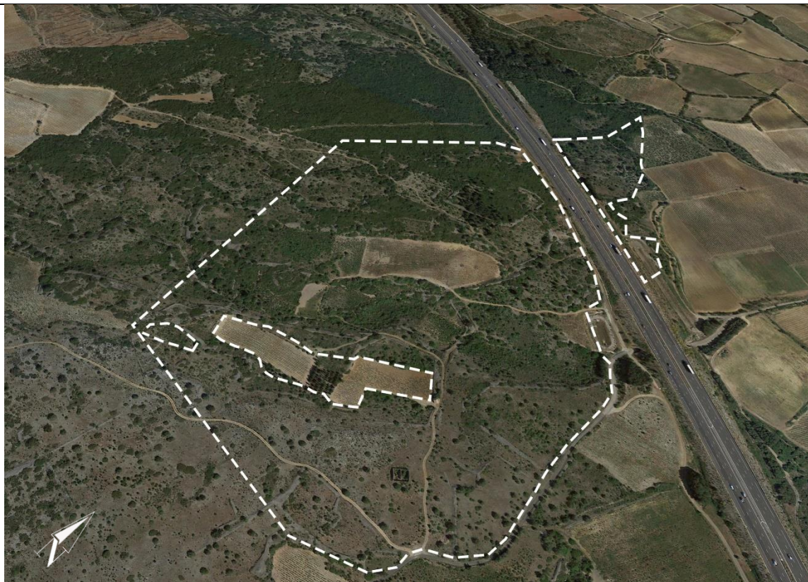
☞ Photographie aérienne des espaces proposés au classement
