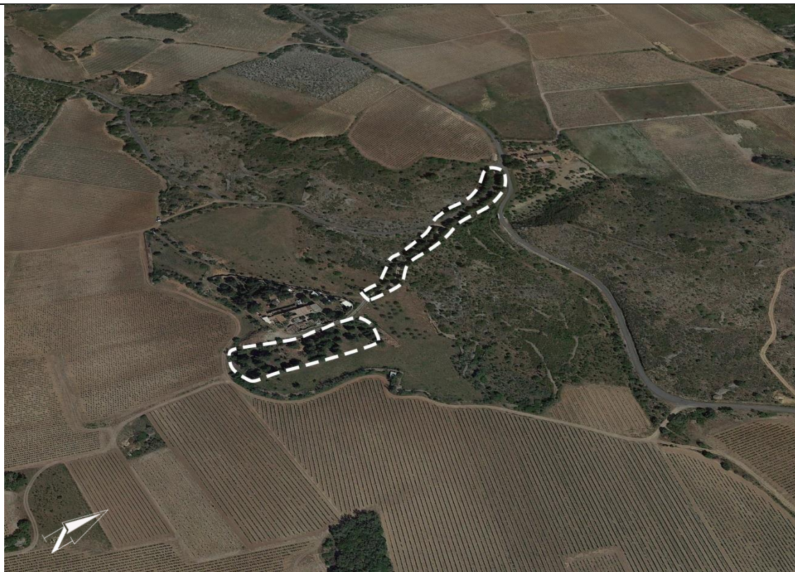
☞ Photographie aérienne des espaces proposés au classement
