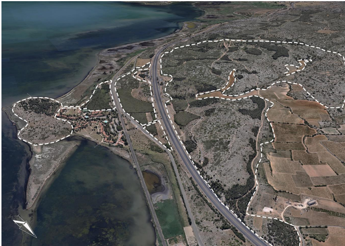
☞ Photographie aérienne des espaces proposés au classement
